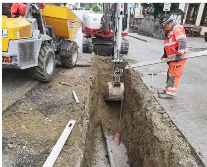
führt, diese sind nun kinderwagen- und rollstuhlfreundlich. Im Zuge dieser Sanierungsarbeiten wurden auch notwendig gewordene Tiefbauarbeiten durchgeführt. Ein neuer Oberflächenkanal wurde verlegt.
