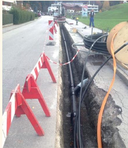
Sehr aufwendig und zeitintensiv gestalten sich die notwendigen Tiefbauarbeiten, da in diesem Zuge auch Versorgungsleitungen für Trinkwasser oder die Straßenbeleuchtung mit verlegt werden bzw. Erneuerungen von Abwasserleitungen und sehr häufig Retentionsbauten oder Versickerungsanlagen für die Entsorgung der Oberflächen- und Straßenwässer neu bzw. ausgetauscht werden müssen.
