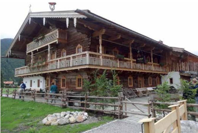
Bogners Sohn in rund 3000 einzelne Holzteile zerlegt und in Rottach-Egern wieder aufgebaut.
